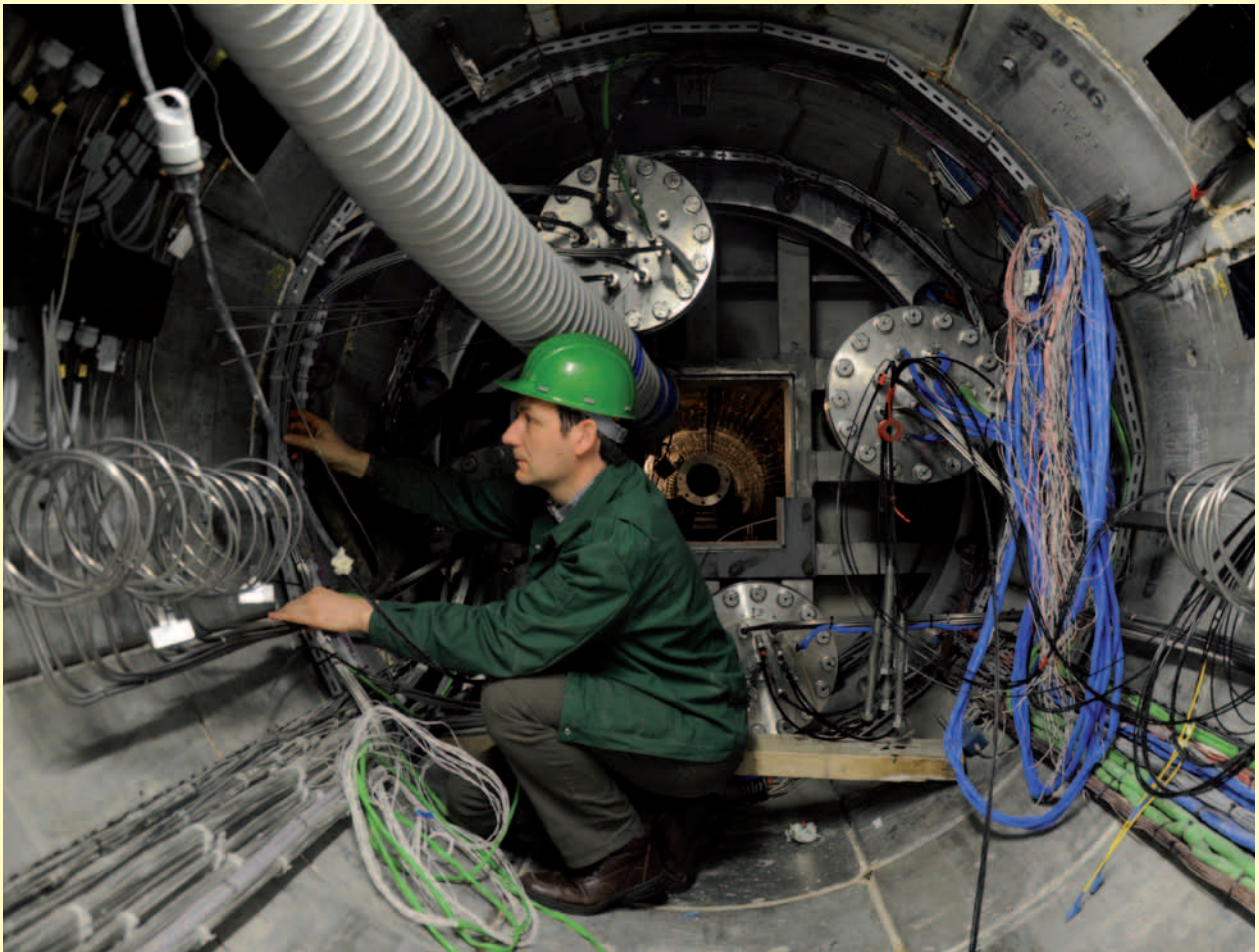
Un chercheur vérifie les instruments de mesure à hauteur de la structure métallique qui obture la galerie.
